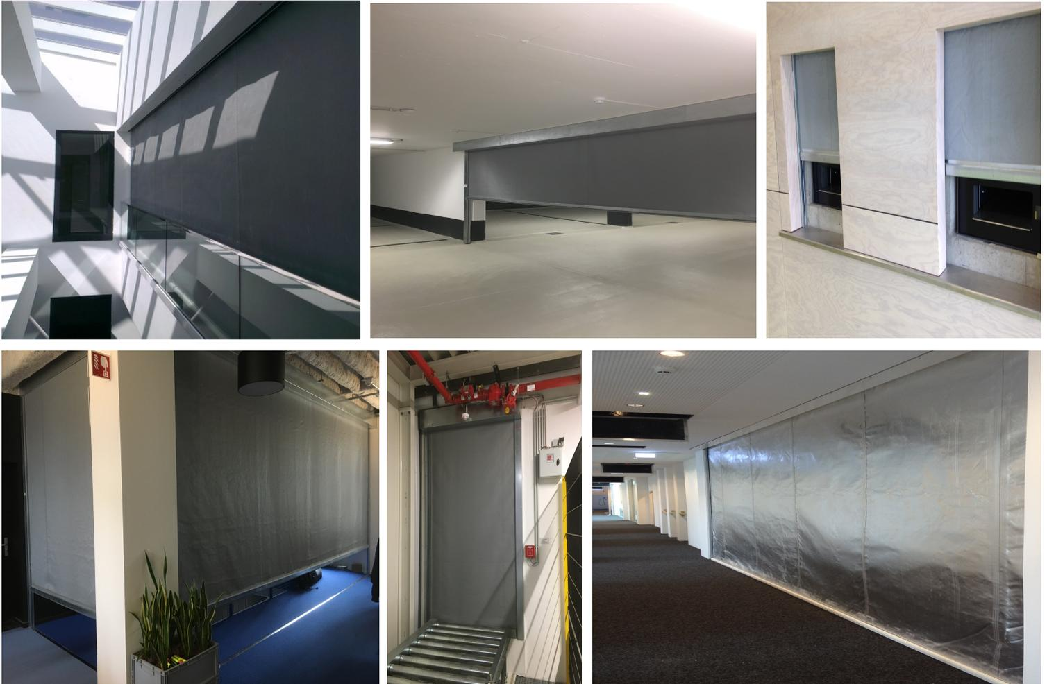
Entsprechend dem Schutzziel, werden diese Anlagen mit unterschiedlichem Behanggewebe ausgestattet. Ein rauchdichtes, beidseitig beschichtetes Glasfilamentgewebe mit Drahtverstärkung als Rauchschutzabschluss, oder ein Verbundgewebe als Feuerschutzabschluss in den Klassen E, EW und EI sind lieferbar.
